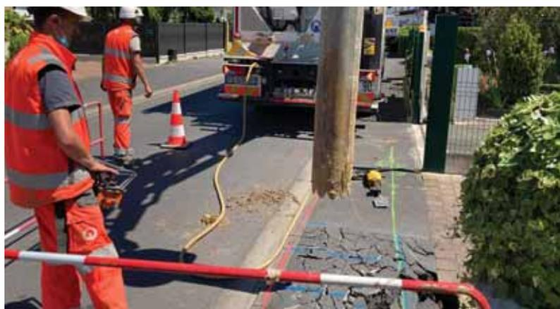
Des analyses métallographiques sont réalisées pour étudier le niveau de corrosion. Grâce à ce scanner du tuyau, les services connaissent la durée de vie du tuyau. En fonction des résultats, des travaux sont menés.
